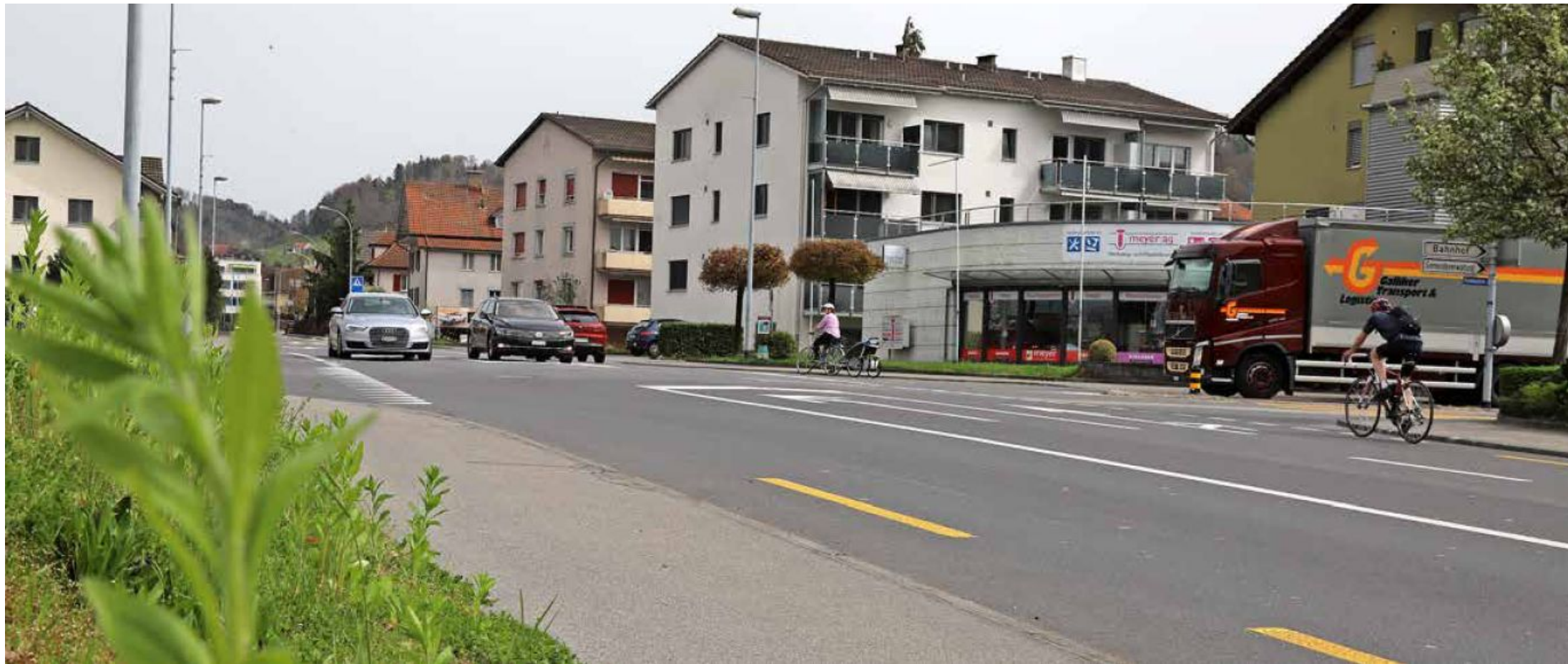
Kanton und Gemeinde wollen die Kreuzung Industrie-, Friedmattstrasse und Pfaffnauerstrasse durch den Bau eines vierarmigen Kreisels entschärfen. Anwohnerinnen und Anwohner wehren sich bereits vor der Auflage des Projekts gegen dieses Ansinnen, weil für sie das Problem damit nicht langfristig gelöst werde. Foto Stefan Bossart
